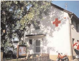
DRK-Haus – nach Umbau
